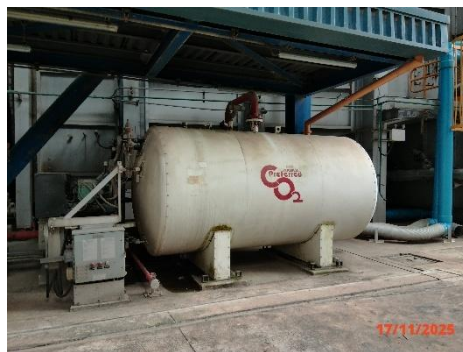
ภาพที่ 2-44 CO 2 Extinguishing System
