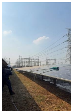
ภาพที่ 2-59 การทำความสะอาดเซลล์แสงอาทิตย์
