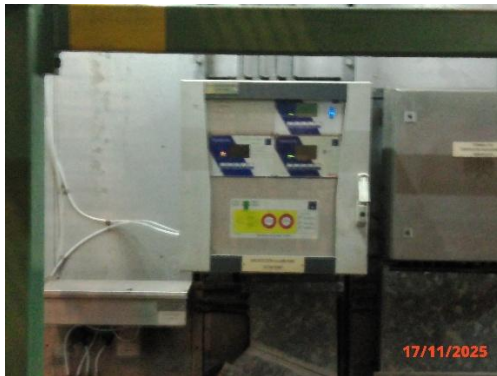
ภาพที่ 2-36 อุปกรณ์ตรวจสอบการรั่วไหลของก๊าซ (Gas Detector)
