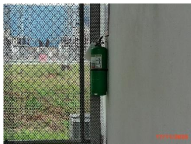
ภาพที่ 2-58 ถังดับเพลิงชนิดผงเคมีแห้ง บริเวณห้อง Inverter
