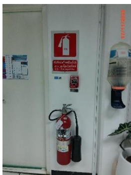
ภาพที่ 2-46 ถังดับเพลิงทั้งแบบผงเคมีและแบบก๊าซคาร์บอนไดออกไซด์
