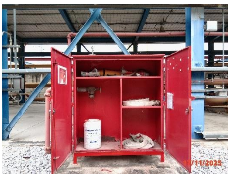
ภาพที่ 2-47 Water Foam Hose Station
