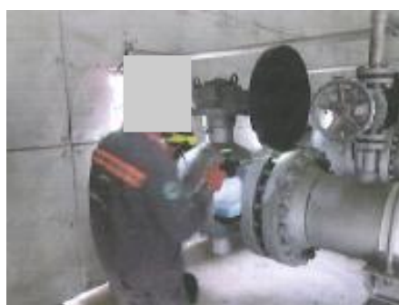
ภาพที่ 2-33 การทำความสะอาดท่อส่งก๊าซธรรมชาติ
