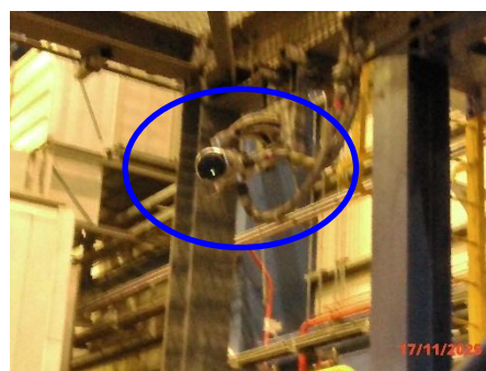
ภาพที่ 2-52 ระบบตรวจจับเพลิงไหม้ บริเวณ Gas Turbine Enclosure (Fire Cross Zone Detection)
