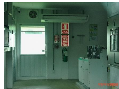
ภาพที่ 2-58 ถังดับเพลิงชนิดผงเคมีแห้ง บริเวณห้อง Inverter
