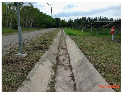
ภาพที่ 2-55 รางระบายน้ำรอบพื้นที่ระบบผลิตไฟฟ้าจากเซลล์แสงอาทิตย์ (Solar Farm)
