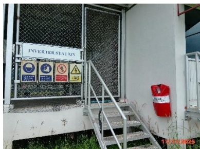
ภาพที่ 2-58 ถังดับเพลิงชนิดผงเคมีแห้ง บริเวณห้อง Inverter
